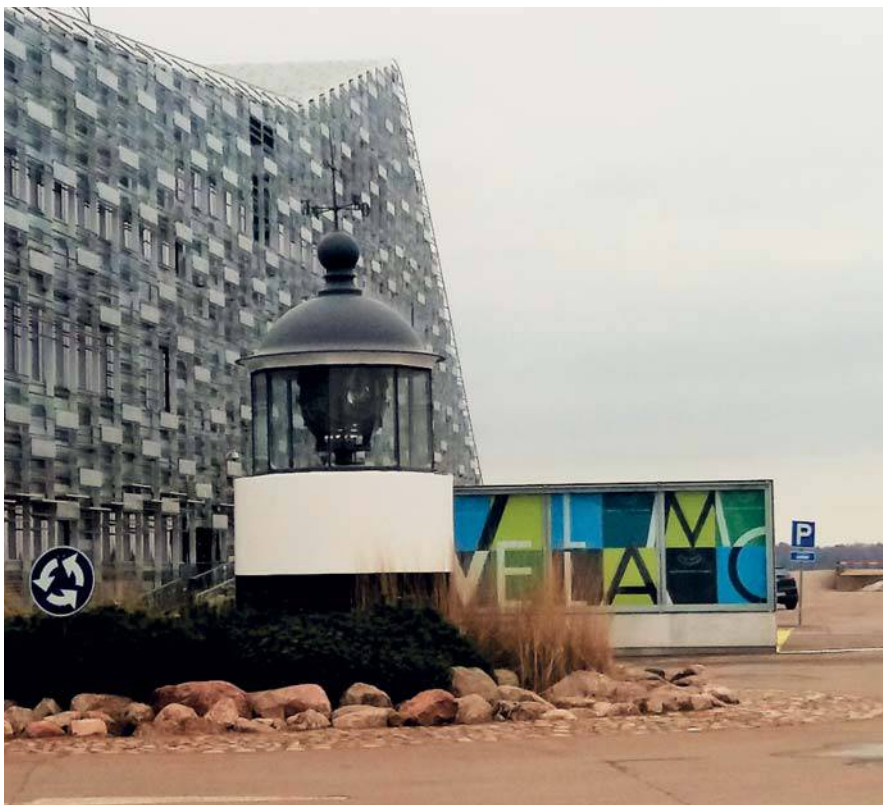
Merikeskus Vellamo on huomiota herättävä rakennus Kotkan satamassa.
